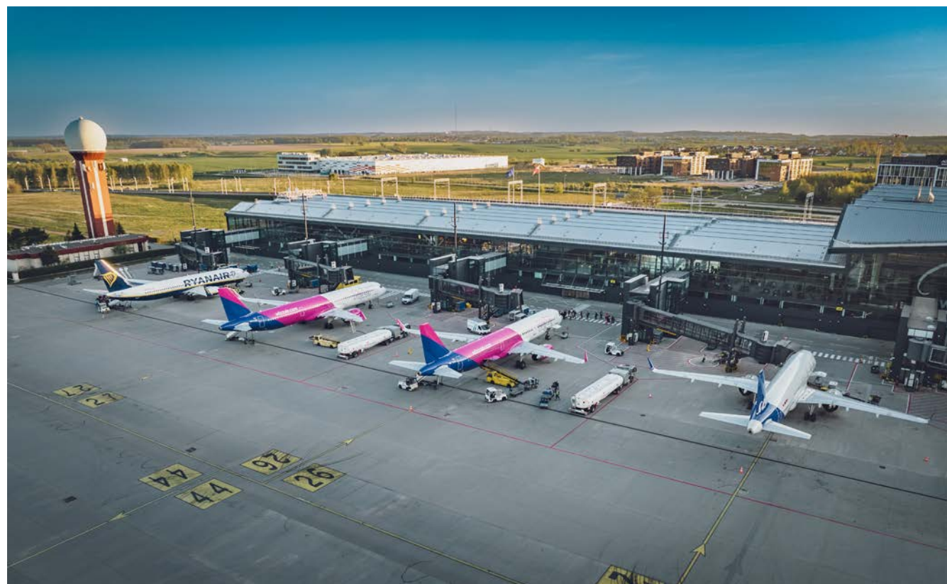
▲ Terminal T2 po dobudowaniu pirsu w 2023 roku.
